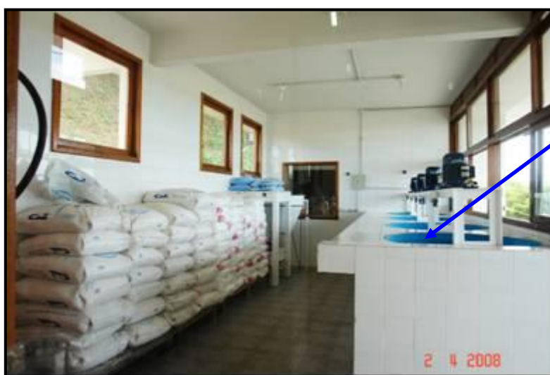
Figura 4.4: Sala de preparo de soluções da ETA de Casimiro de Abreu.
