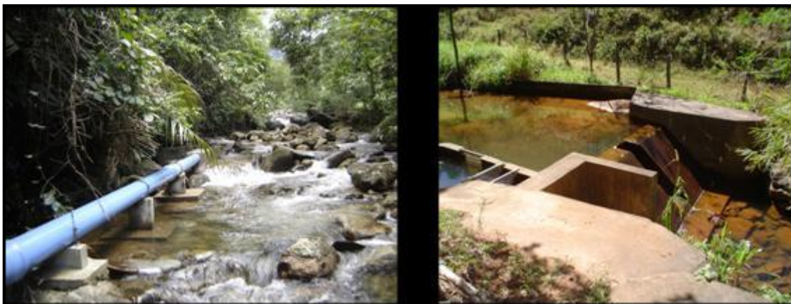
Figura 4.3: Captações por gravidade do sistema de tratamento de água de Casimiro de Abreu.
